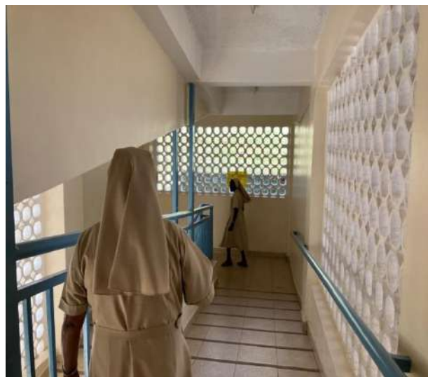
Foto 8: Rampas de acceso a las aulas
