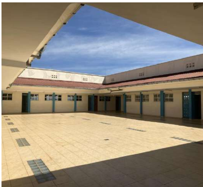
Foto 4: Patio interior en la planta primera del centro Amani
